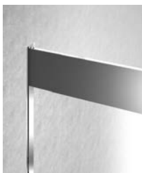
Variante mit Unterputzprofil
